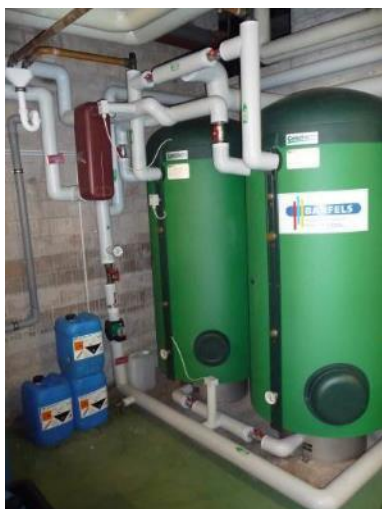
Warmwasserbereitung Schwimmhalle
