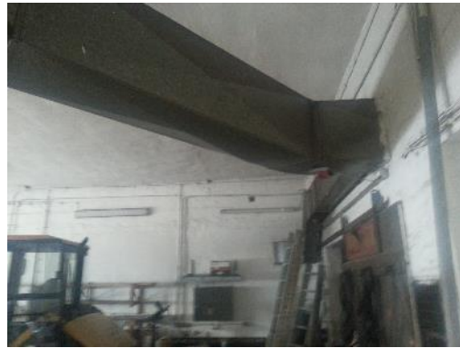
Lüftungskanäle Warmluftheizung
