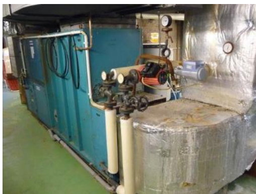
Lüftungsgerät Nebenräume
