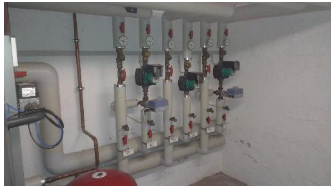
Bild 04: Heizwärmeverteilung
