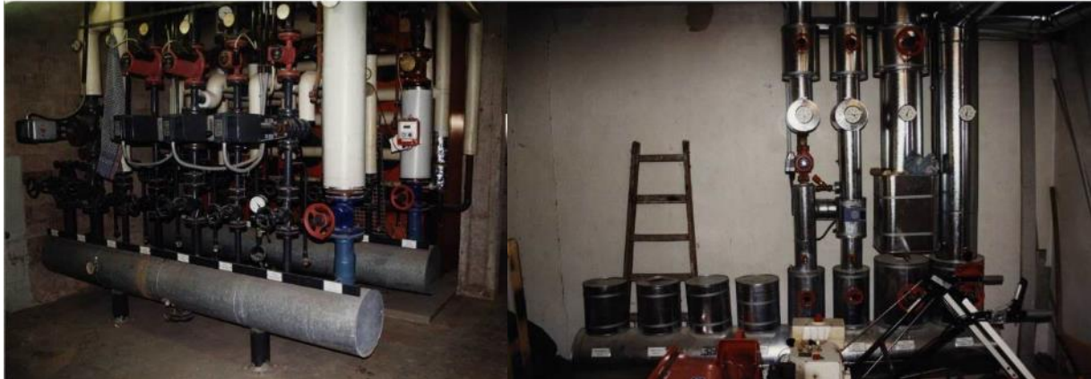
Heizkreisverteiler Schwimmhalle
